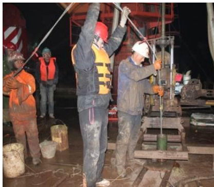
图 34 SAA 位移传感器布设过程
